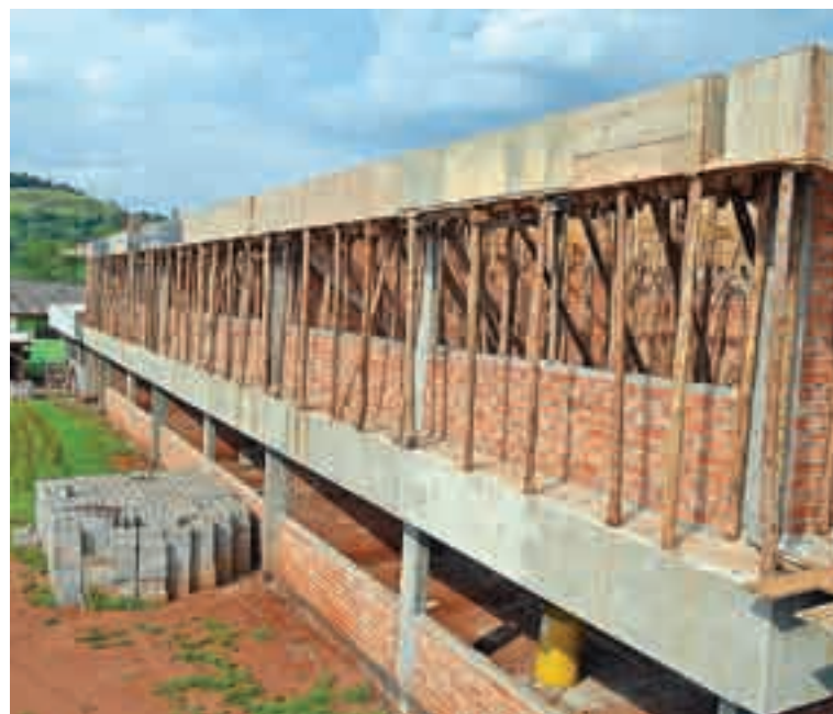
As obras da Escola São Luiz estão em andamento, com previsão para entrega no próximo ano letivo
